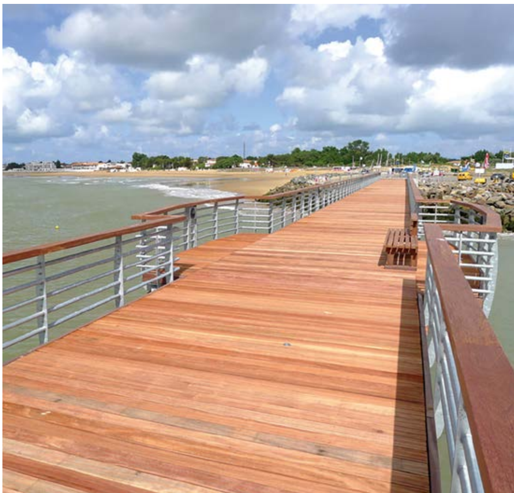
Estacade . La Tranche-sur-Mer (85) Fourniture des lames en Tali profil Équateur
