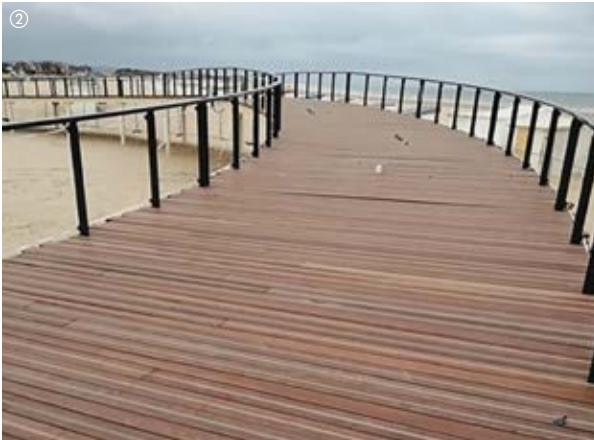
② Belvédère de Blériot Plage . Calais (62) Lames Maçaranduba avec incrustation de résine Époxy et Corindon dans rainure queue d'aronde
